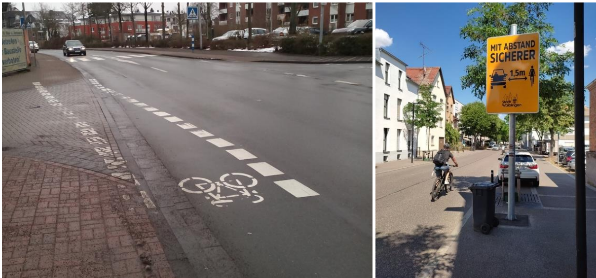
Abbildung 43: Piktogramm beim Übergang des Radwegs auf die Fahrbahn (links) und Hinweisschild (rechts)
