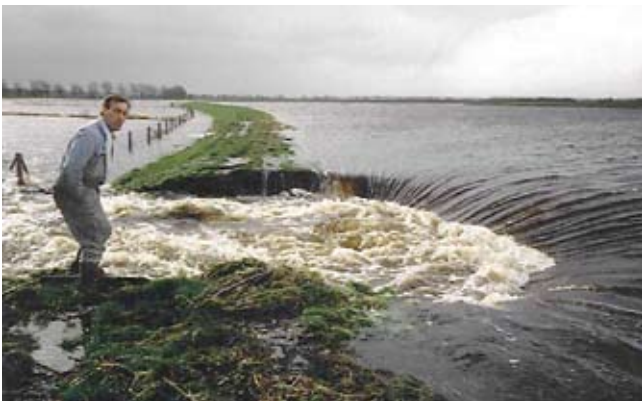
Abb. 2: Deichbruch an der Treene bei Bünge 1998
