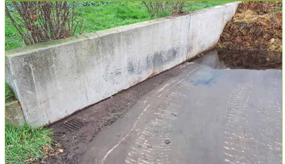
Bild 5: Festmistlager mit funktionstüchtigem Einlauf zum Sammelbehälter
