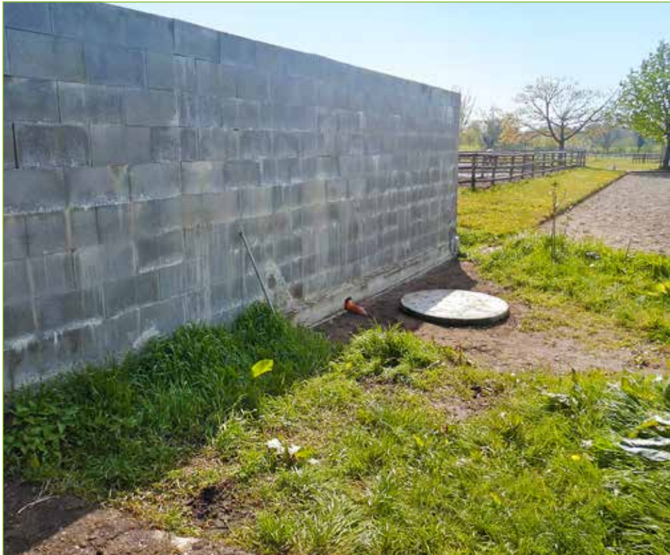
Bild 6: Festmistlager mit Ableitung in einen Sammelbehälter
