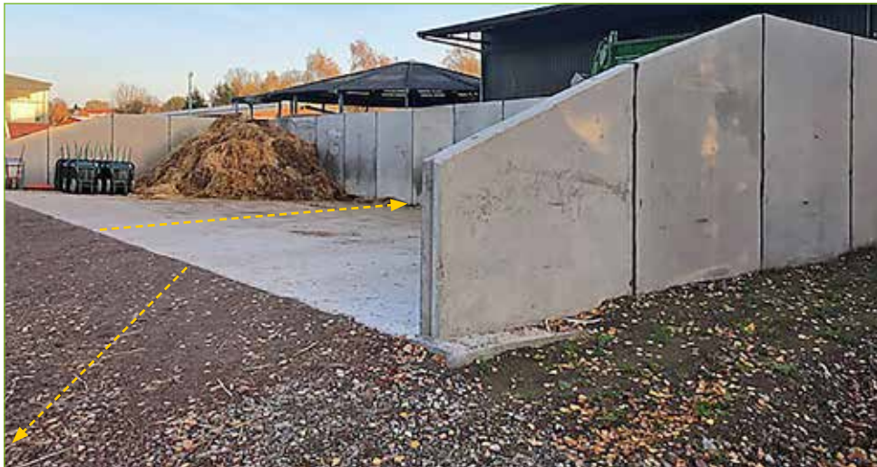
Bild 4: Festmistlager mit Gefälleausbildung und flüssigkeitsundurchlässigen Seitenwänden
