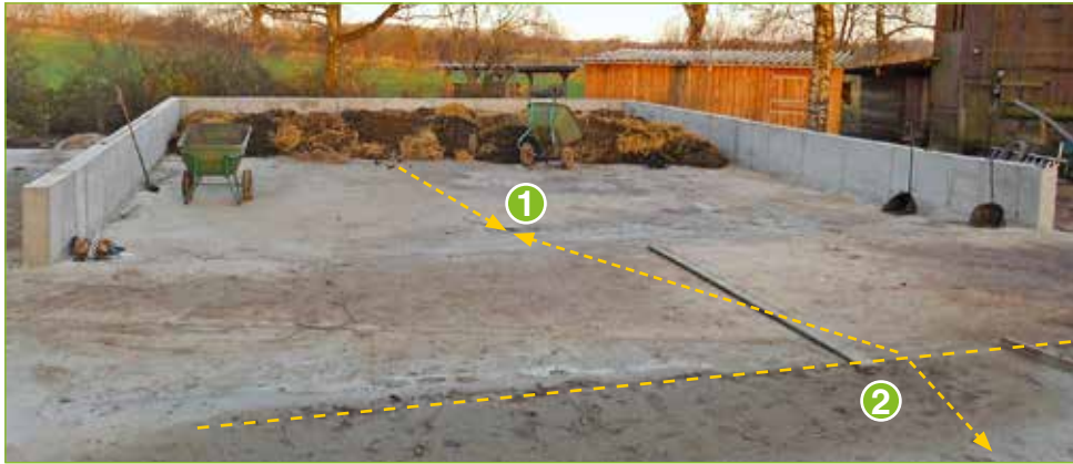
Bild 3: Seitlich eingefasstes Festmistlager mit Sammelbehälter und Gegengefälle
