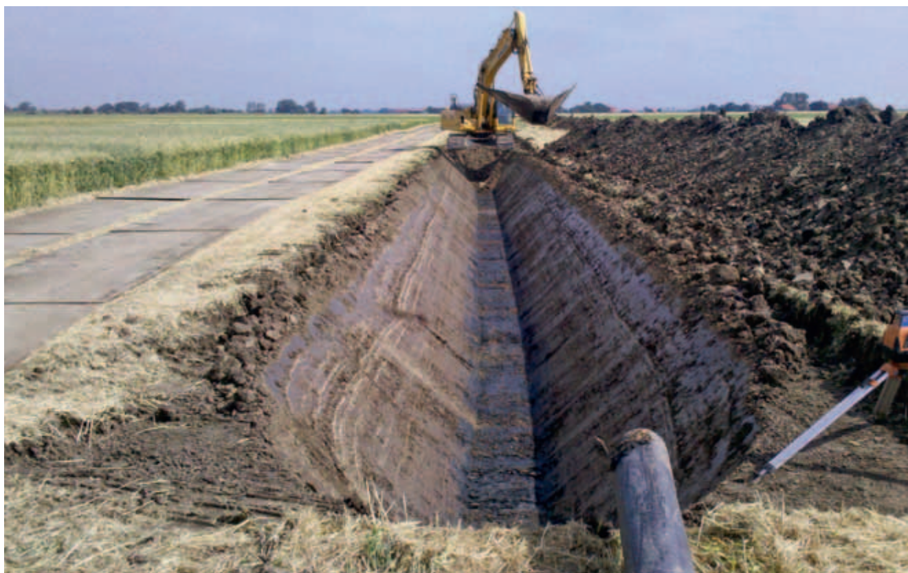
Abbildung 4: Ausheben eines Leitungsgrabens in einer Kalkmarsch
