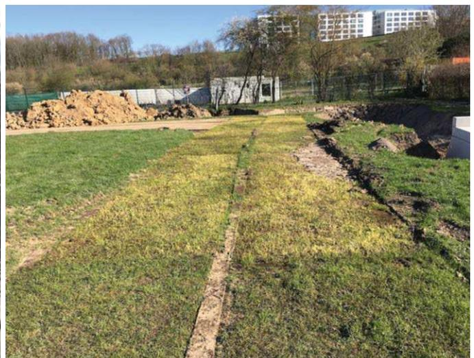
Abb. 4: Lastverteilungsplatten während (links) und Oberfläche nach Rückbau der Baustraße (rechts) bei einer Gewässerumbaumaßnahme (Bauzeit: 1,5 Monate) (ahu GmbH)
