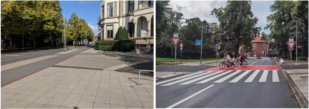
Abbildung 45: Gehwegüberfahrt (links) und bevorrechtigter, eigenständig geführter Geh- und Radweg (rechts)
