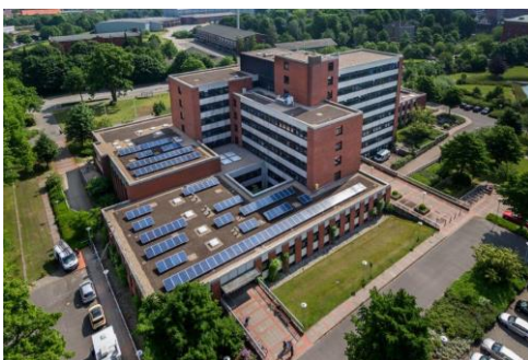
Abbildung 7: Kreishaus Rendsburg – Aufdach-PV-Anlage
